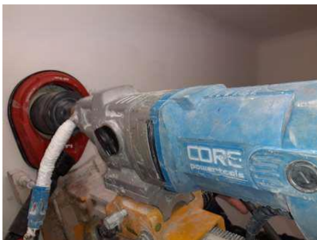
Image 8 : carottage à l'aide d'un appareil à eau et d'un système de récupération des boues (détail). ©AD Marne
