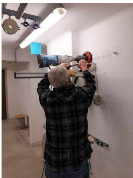
Image 7 : carottage à l'aide d'un appareil à eau et d'un système de récupération des boues. ©AD Marne
