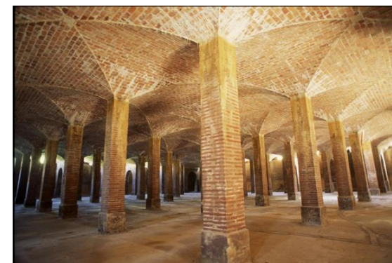
l'intérieur en cours d'assèchement avant travaux
