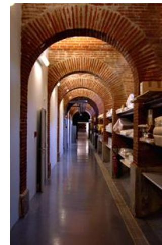
un couloir desservant les magasins en sous-sol
