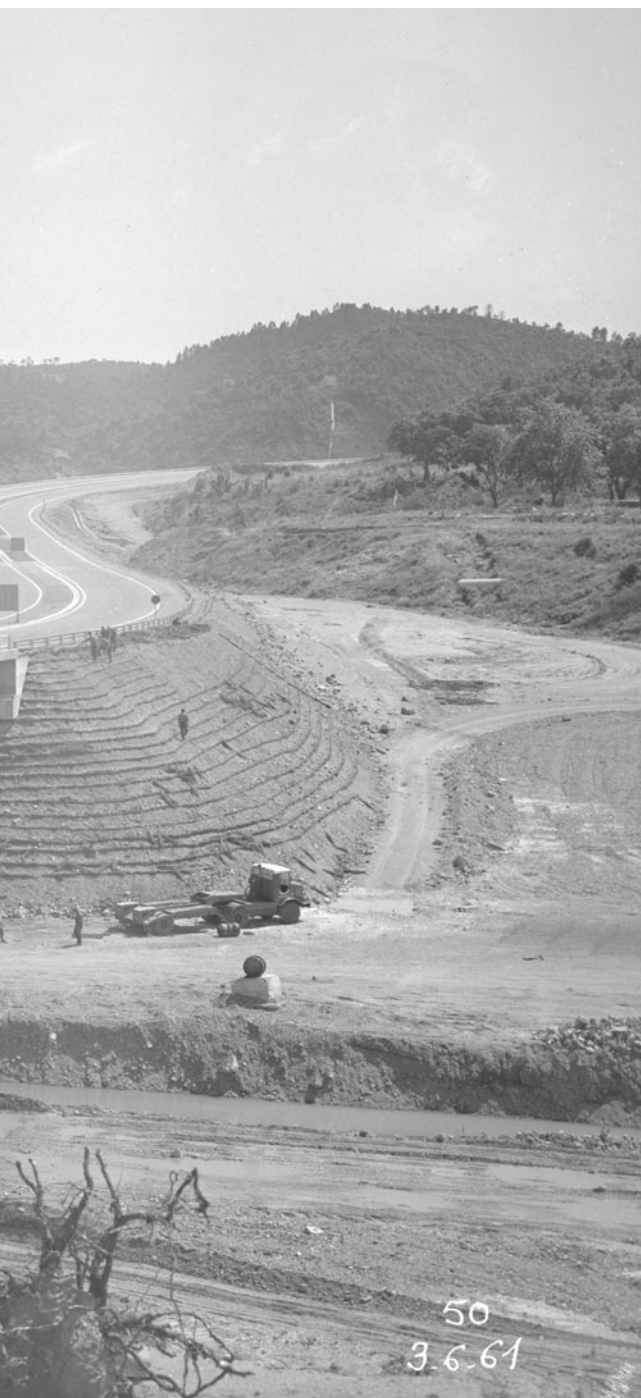
Pont autoroutier au dessus du Reyran (Fréjus).
